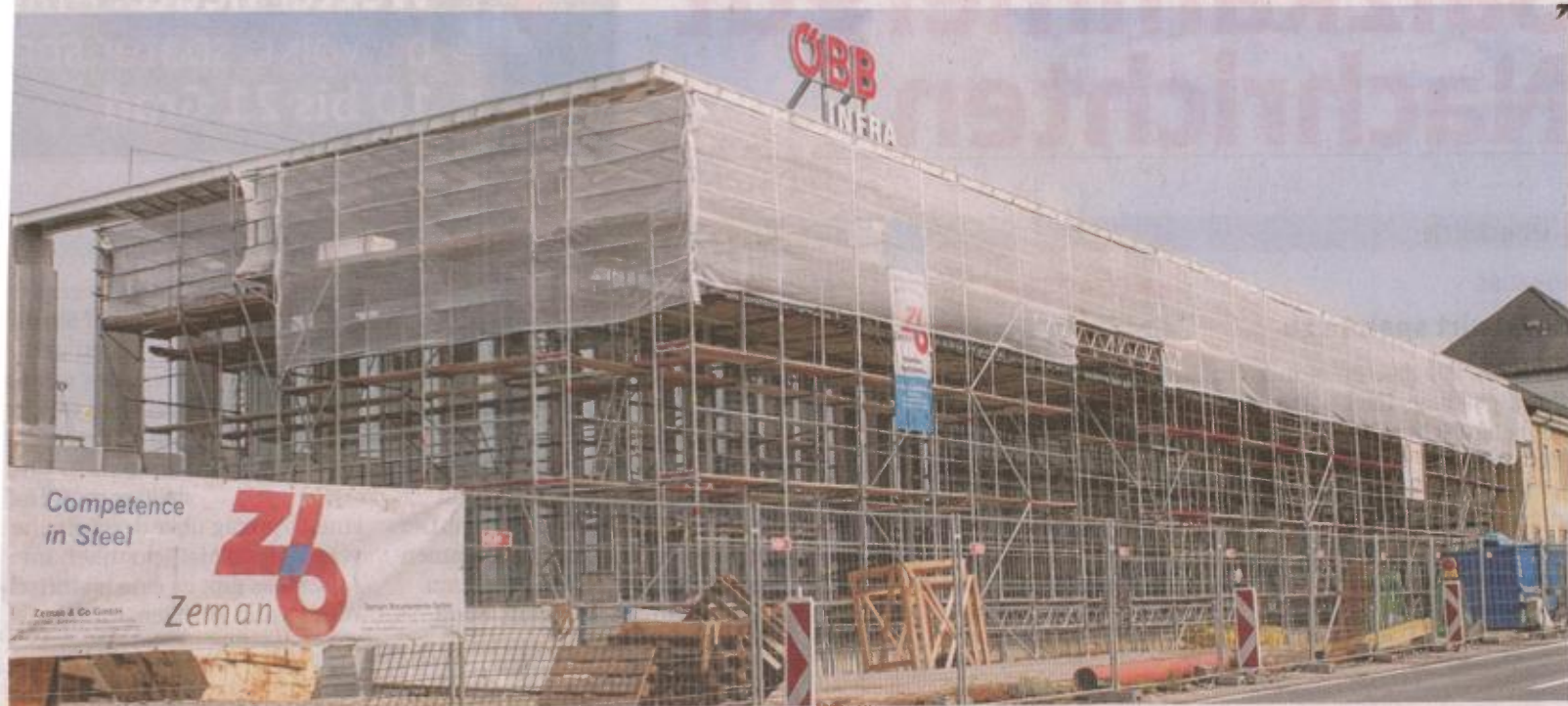
Die Glasflächen garantieren einen guten Lichteintrag in das neue Bahnhofsgebäude, das in einer modernen Architektur geplant wurde.
