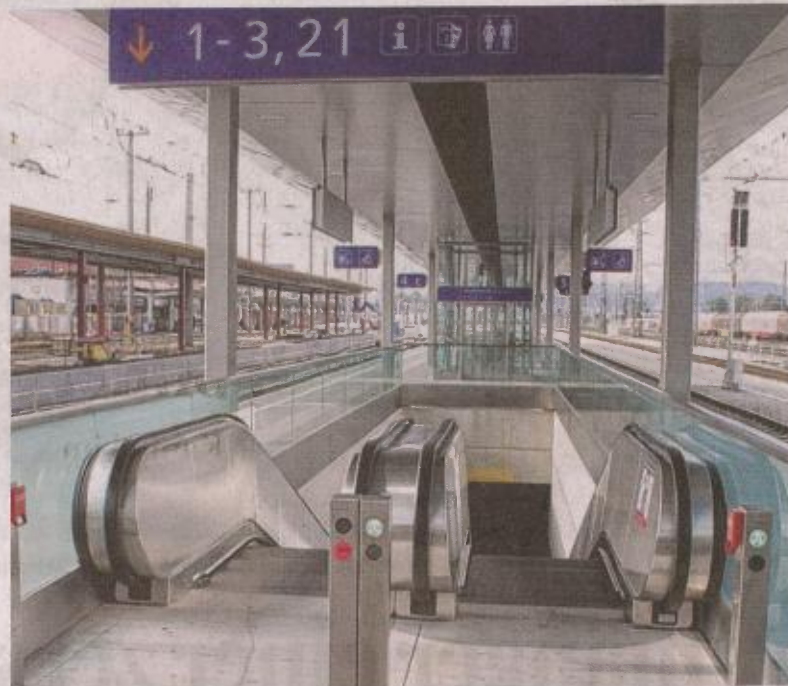
Die neuen Bahnsteige sind barrierefrei erreichbar.
