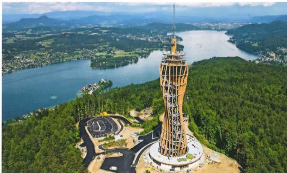
Aussichtsturm aus 300 m 3 Holz und 300 t Stahl. Bilder: Rubner
