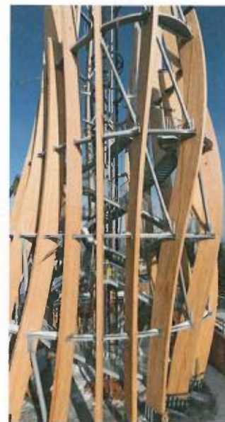
27 m lange Brettschichtholz-Träger und jeweils um 22,5 Grad versetzte Ebenen.
