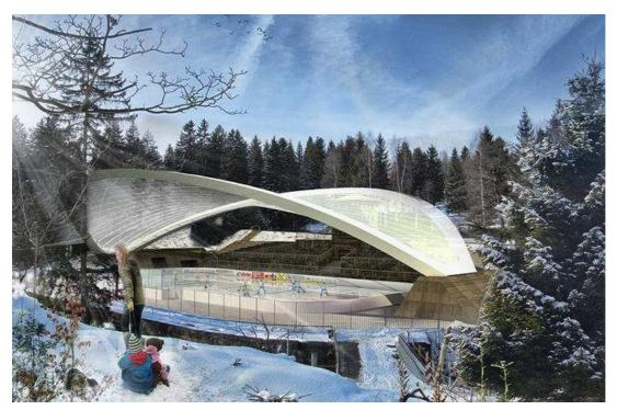
Die 300 Tonnen schwere Stahlkonstruktion spannt sich über 73 Meter. © Stadt Wernigerode, Hoch- und Tiefbauamt
