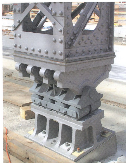
Bild 2 Restaurierte Stahlkonstruktion mit Nietkopfschrauben
