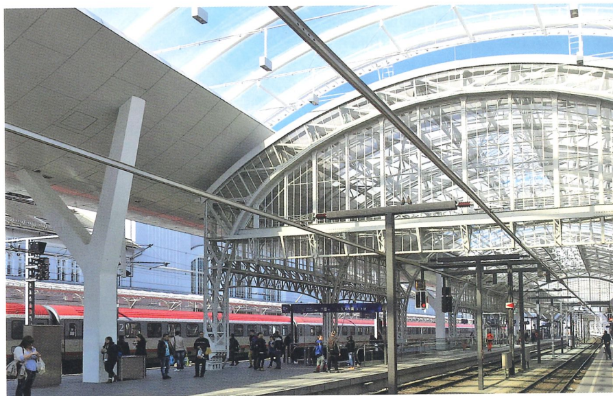
Bild 3 Die historischen Stahlhallen werden von einem modernen Großflächendach umschlossen
