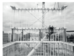
Die Stahlkonstruktion des Turms
