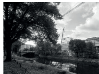
Blick von Südosten über den Landwehrkanal, die Konstruktion des Turms hat die volle Höhe erreicht
