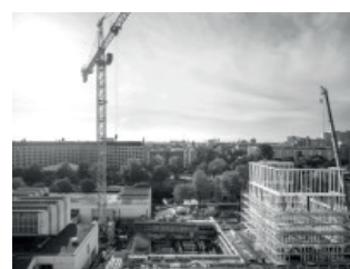
Blick von Nordwesten auf die Baustelle, links der Altbau
