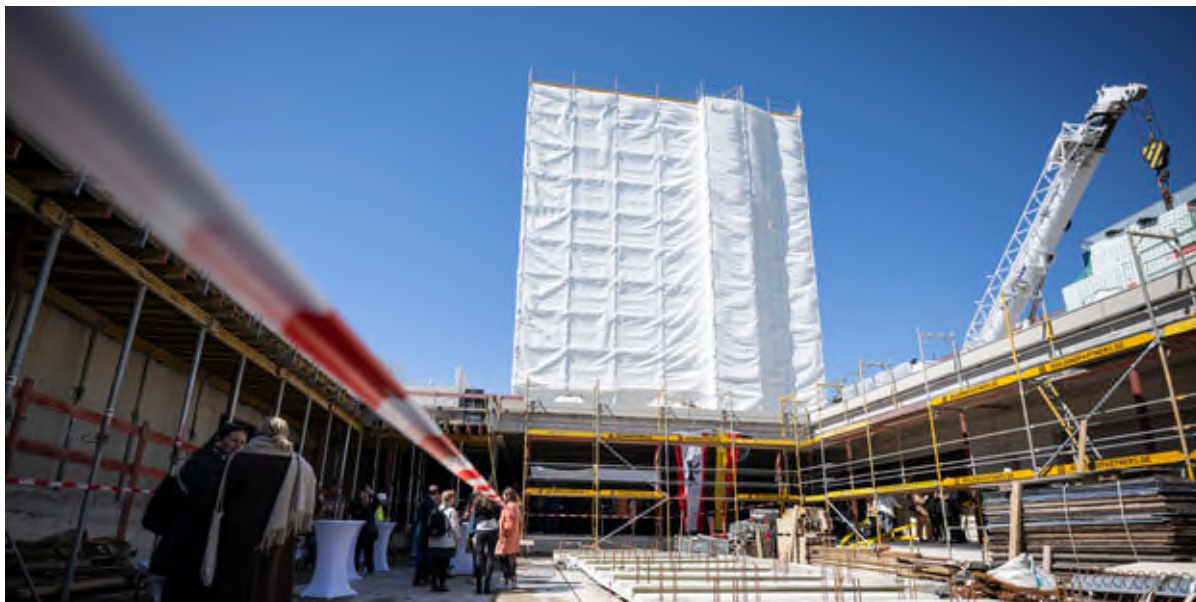
Noch nicht viel zu sehen: Die Erweiterung des Bauhaus-Archives beim Richtfest
