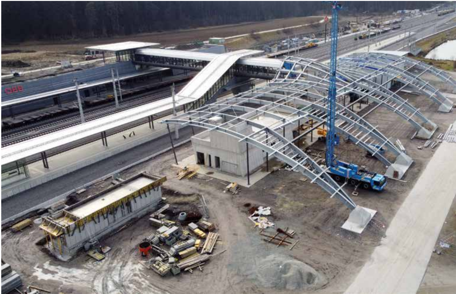
Montage des Stahlbaus des Aufnahmegebäudes
