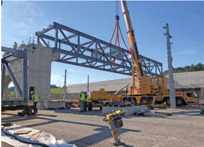
Montage des Stahltragwerks mit Autokran
