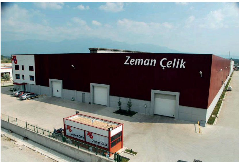
Produktionshalle Production hangar
