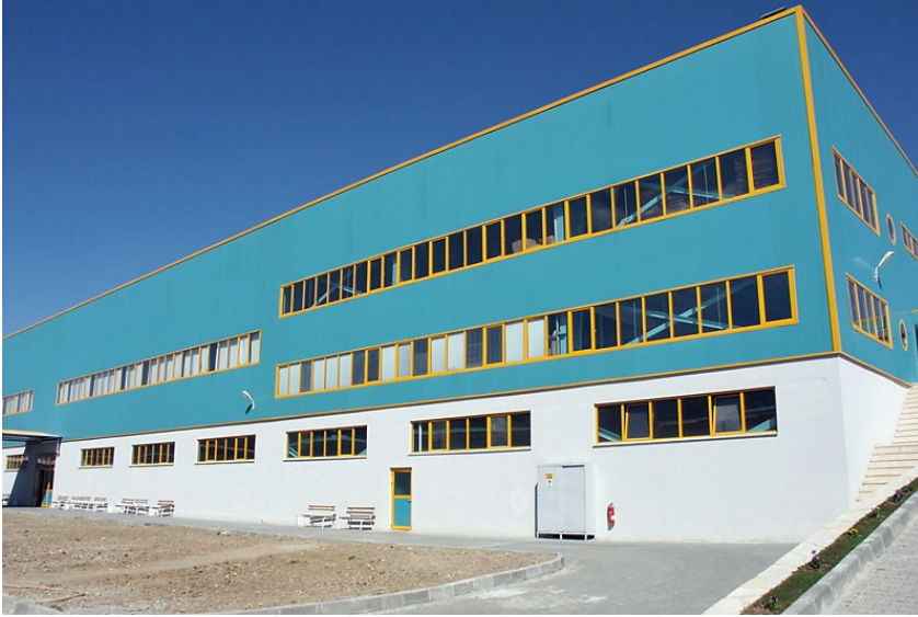
Ausführungsbeispiel Fabrikationshalle, Safranbolu, Türkei Executed project: Production hangar, Safranbolu, Turkey
