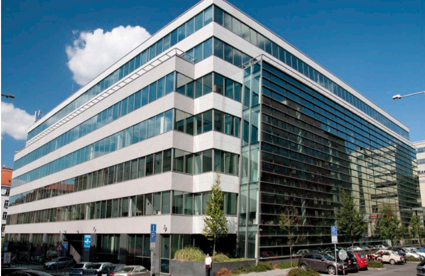
Verwaltungsgebäude Administration building
