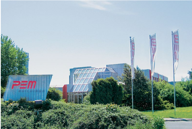
Verwaltungsgebäude Administration building
