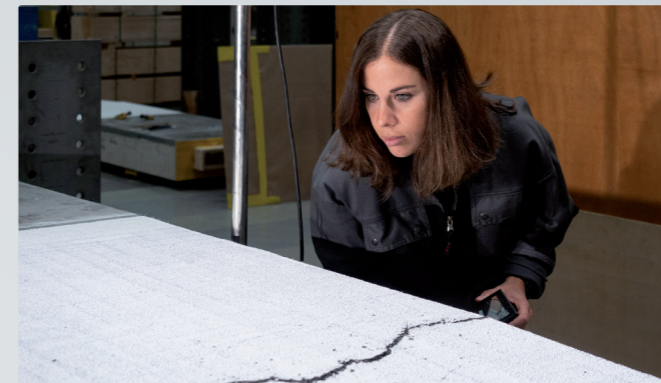
➔ Unter Spannung: Empa-Forscherin Angela Sequeira Lemos und ihr Team haben die Betonplatten in Versuchen bewusst zu Riss gebracht.
